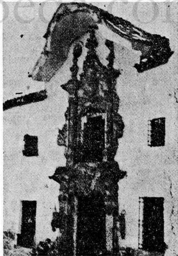
Fachada de una casa antigua que fué para recoger los diezmos y que edificó el Obispo Zambrana, hijo de aquella villa.
